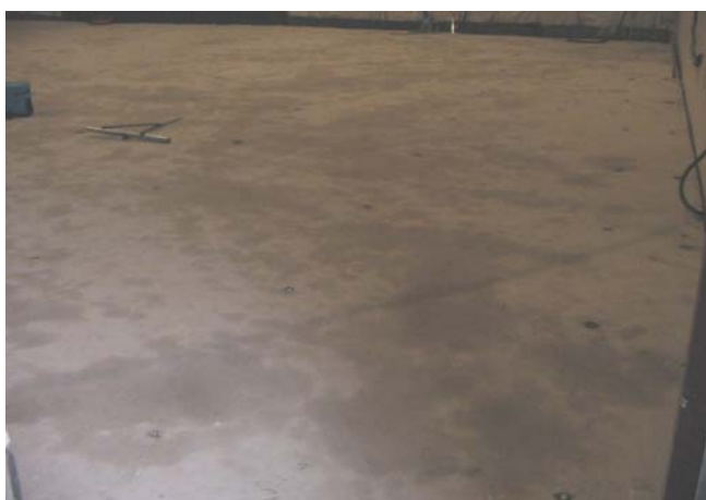
待浮筑地板凝固后 完成浮筑地板提升工序
