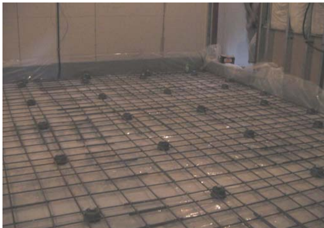
安装队伍根据我司设计 铺设 MASON 自升式减震器
